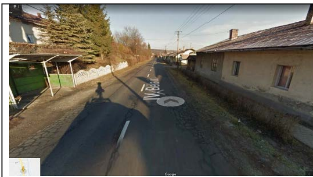
Járdánháza 1+100 km szelvény térségében Meglévő folyópályás buszmegállók.
